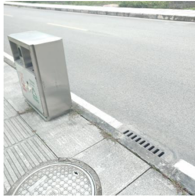
石林支路雨水下水道入口及垃圾箱
