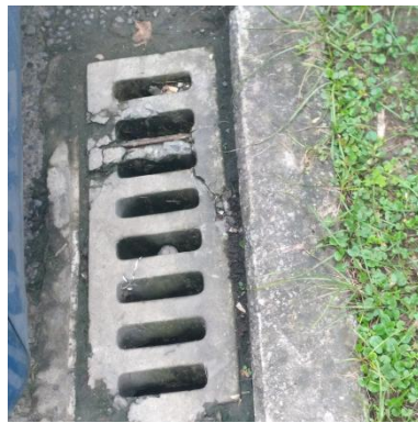
马湾路雨水下水道入口
