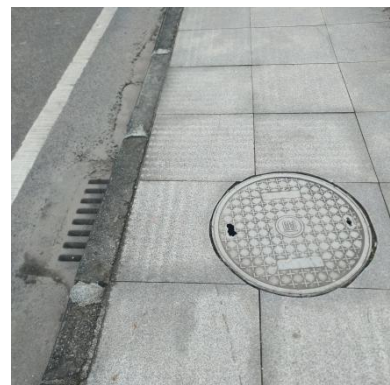
双河口路雨水下水道入口
